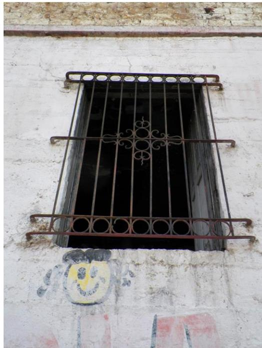
Foto 17. Ventana Sur, herrería de protección forjada a mano (Fotografía Guillermo Escobar, 2020).
