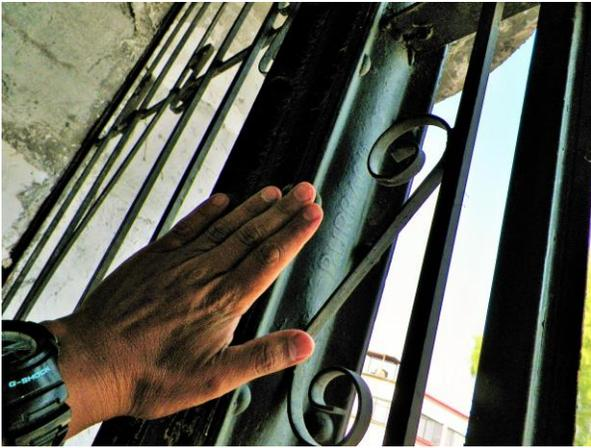
Foto 15. Poste de acero forjado con escala humana (Fotografía Guillermo Escobar, 2017).
