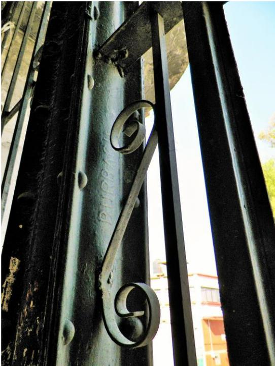
Foto 13. Poste de acero forjado con la marca "BURBACH" (Fotografía Guillermo Escobar, 2017).
