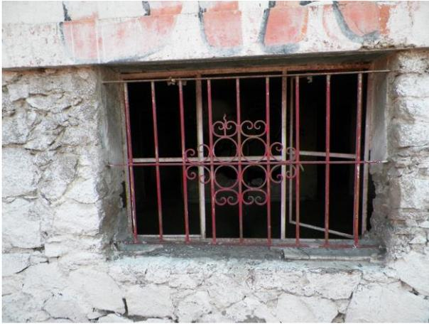
Foto 18. Herrería forjada a mano para proteger la ventana del lado Sur del sótano (Fotografía Guillermo Escobar, 2020).
