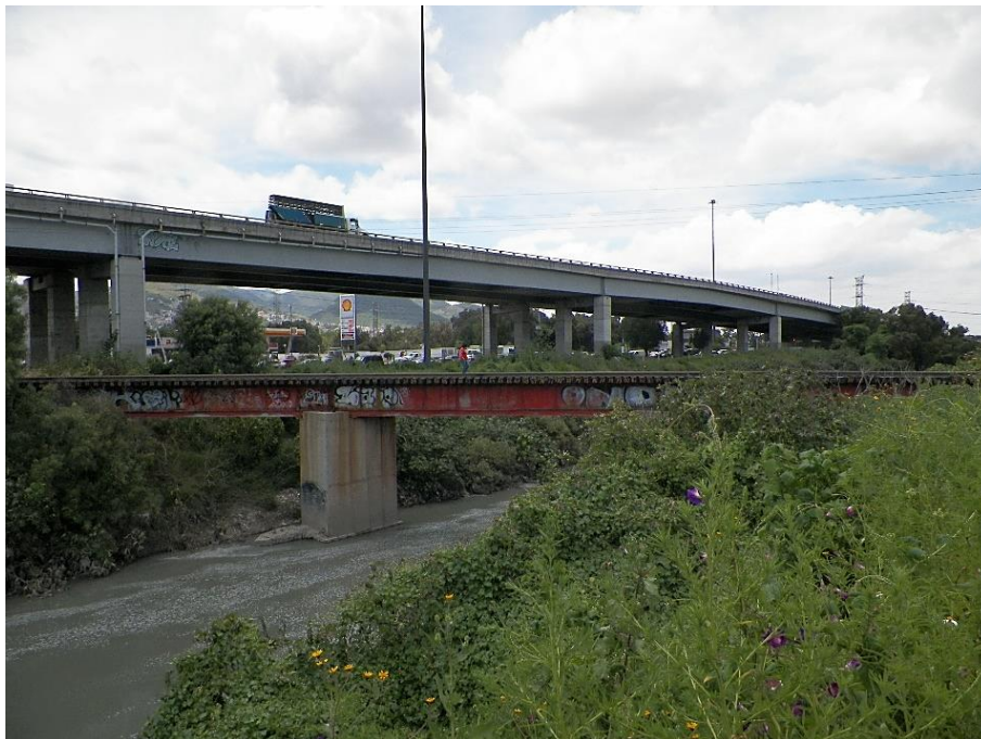
Foto 9. Puente del Ferrocarril Mexicano que se apoya actualmente en dos pilares de cemento (Fotografía Guillermo Escobar, 2021).
