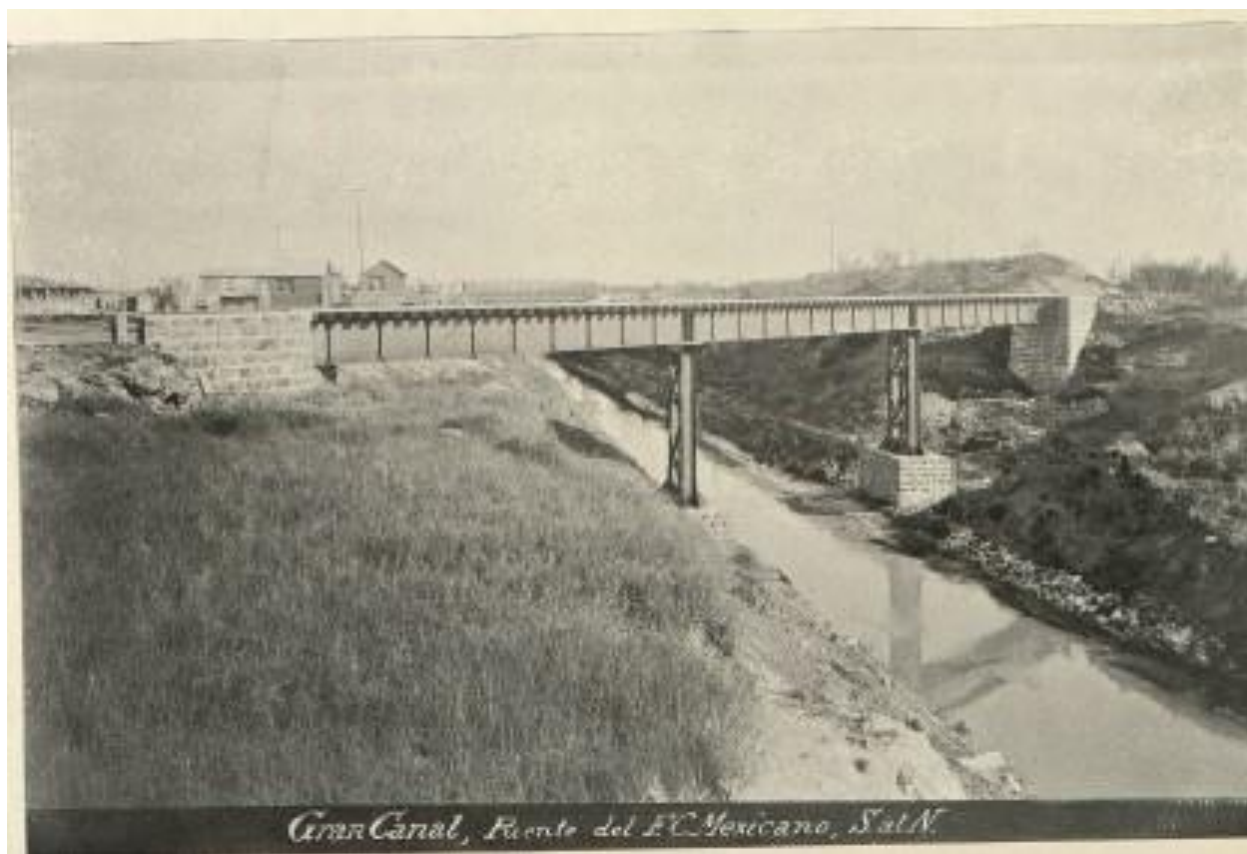
Foto 2. Puente del Ferrocarril Mexicano de 45 metros de longitud, que se apoyaba en dos machones de mampostería en las orillas del canal y dos pilares de fierro sobre basamentos de mampostería (Junta Directiva del Desagüe, 1902).
