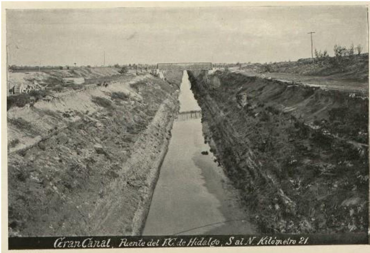
Foto 11. Puente del Ferrocarril Hidalgo sobre el Gran Canal del Desagüe, vista Sur – Norte (Junta Directiva del Desagüe, 1902).
