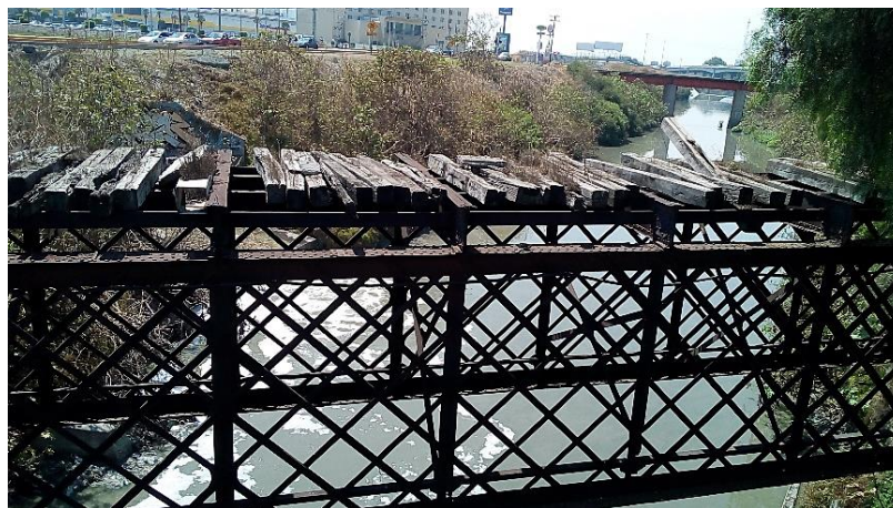
Foto 1. Puente del Ferrocarril Hidalgo y Nordeste en primer plano; y en el fondo se observa el puente del Ferrocarril Mexicano (Fotografía Guillermo Escobar, 2017).
