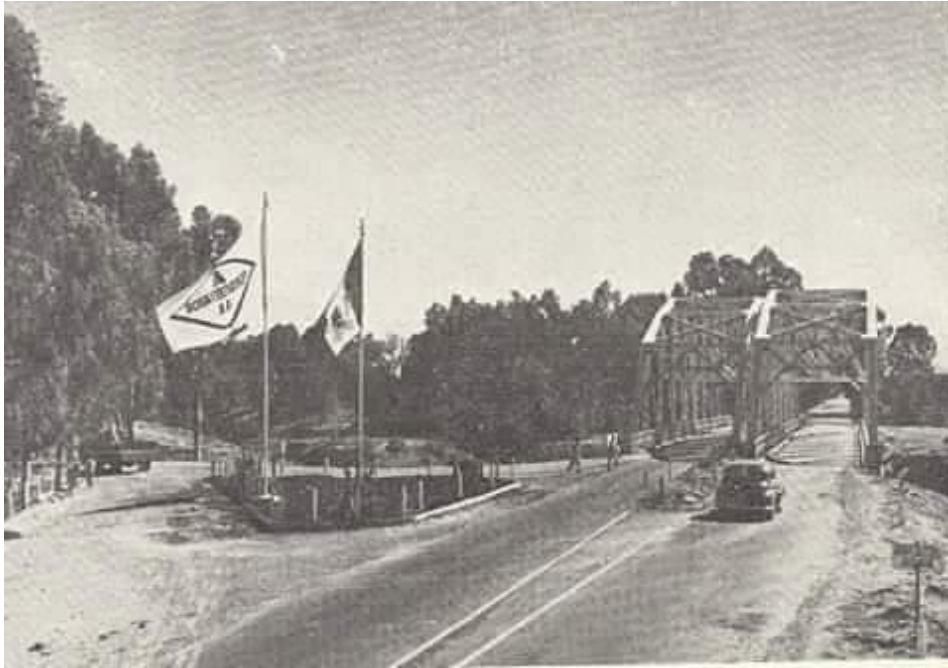
Foto 2. Entronque de la carretera privada que conducía a las plantas de la Empresa Sosa Texcoco, S. A., con la Carretera México-Nuevo Laredo (Carretera a Pachuca), en el kilómetro 22; y puentes sobre el Gran Canal del Desagüe (Sosa Texcoco, S.A., 1948).
