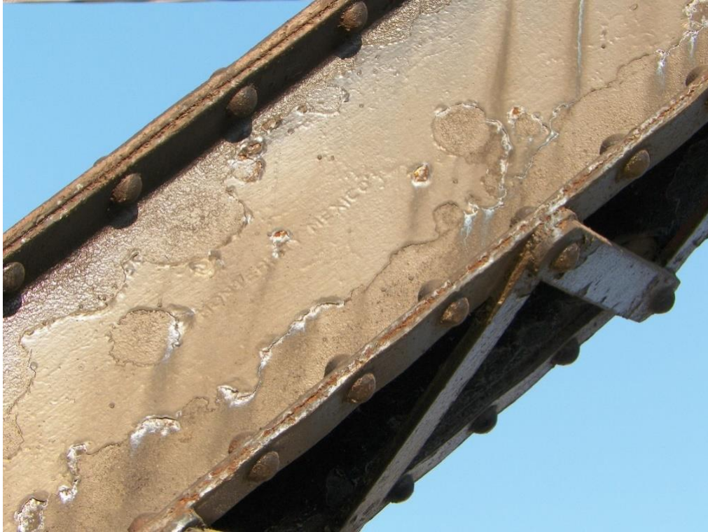
Foto 4. Estructura primaria con la leyenda "MONTERREY MEXICO" (Fotografía Guillermo Escobar, 2023).
