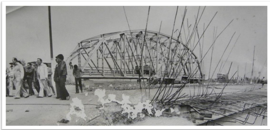
Foto 3. Supervisión de la construcción del puente de concreto sobre el Gran Canal del Desagüe a un costado del Puente de Fierro en el año de 1977 (Archivo Municipal de Ecatepec de Morelos).
