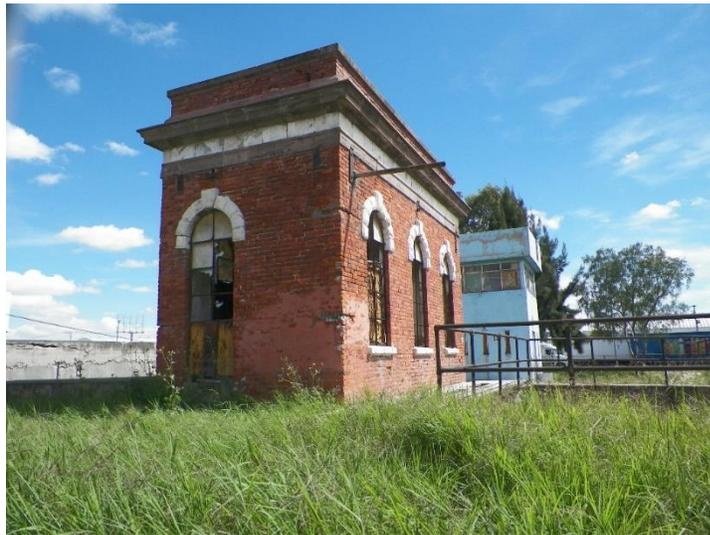
Foto 2. Cuarto de máquinas manufacturado en ladrillo rojo, mármol blanco y cantera rosa (Fotografía Guillermo Escobar, 2021).
